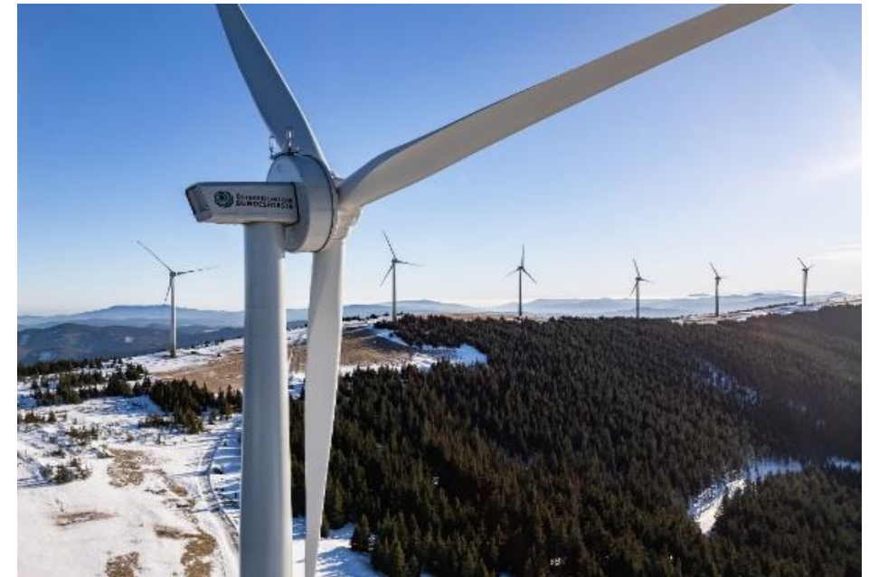
Talmulde, komplett aufgeschottert → Zuwegung zur WEA
