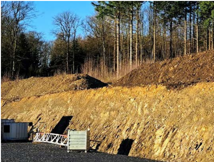
Vorschriftsgemäß angelegte Mieten für Unterboden (links) und Oberboden (rechts)
