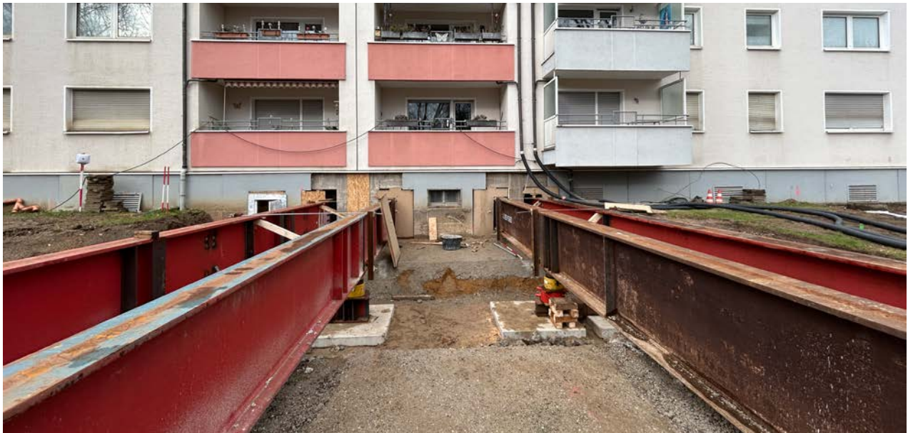
Bild 13.6 Frontale Ansicht auf das Traversensystem
