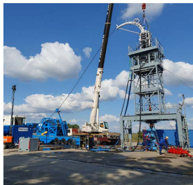
Bild 11.3 Eine aufgebaute CT-Anlage mit Turmgerüst auf einer Gasspeicherbohrung
