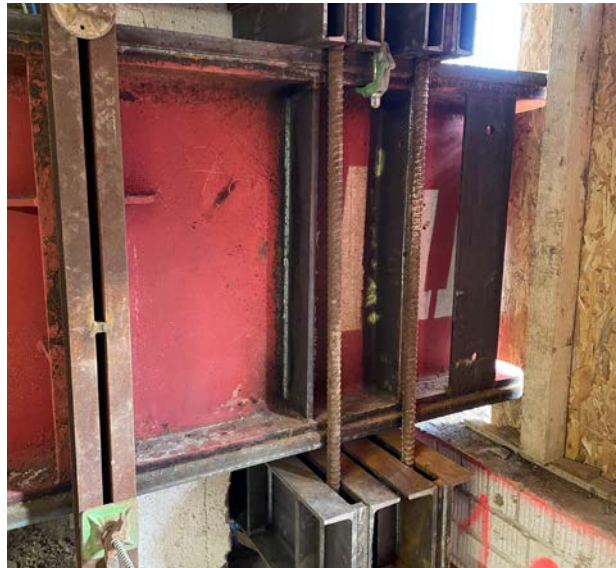
Bild 13.3 Jochträgersystem Einbau der Traverse Quelle: Bezirksregierung Arnsberg
