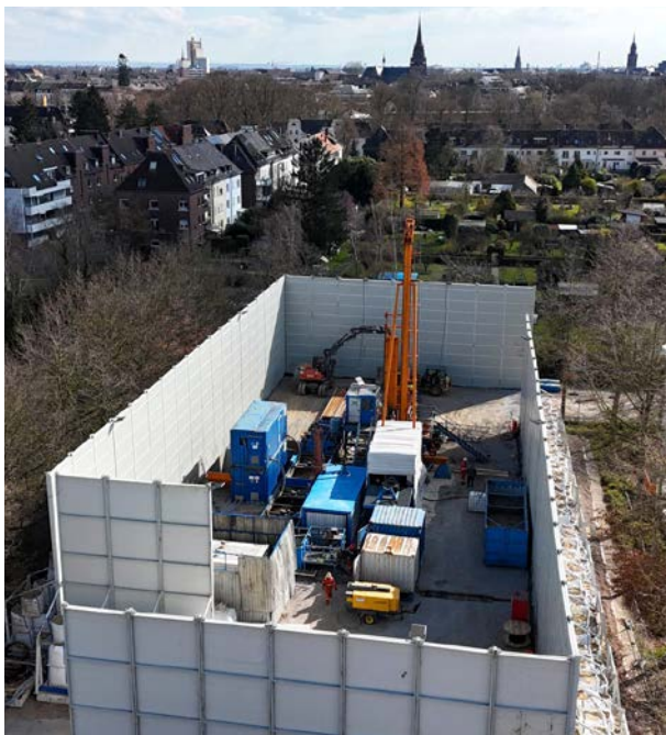
Bild 10.3 Bohrplatz Geologischer Dienst NRW Forschungsbohrung in Krefeld Quelle: Geologischer Dienst NRW
