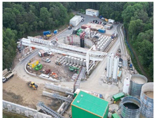
Bild 6.7 Mittelschacht – Tagesanlagen der Vortriebsphase Quelle: RAG AG
