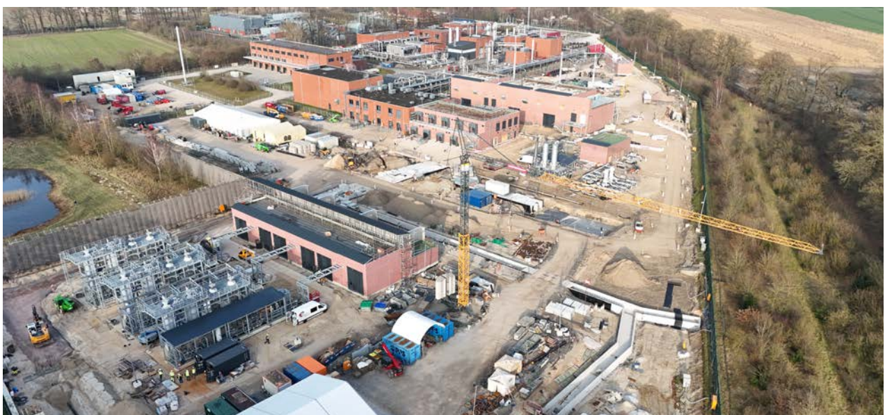
Bild 11.1 RWE H2-Baustelle im Kavernenfeld Epe aus der Vogelperspektive Quelle und Freigabe: RWE Gas Storage West GmbH
