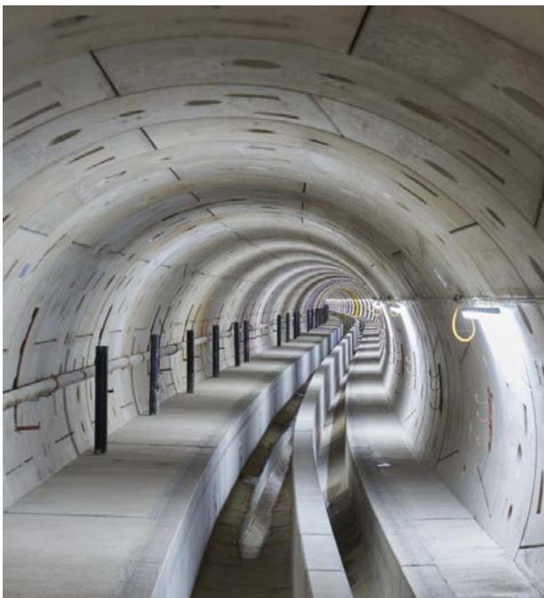
Bild 6.4 Tunnelröhre mit Gerinne
