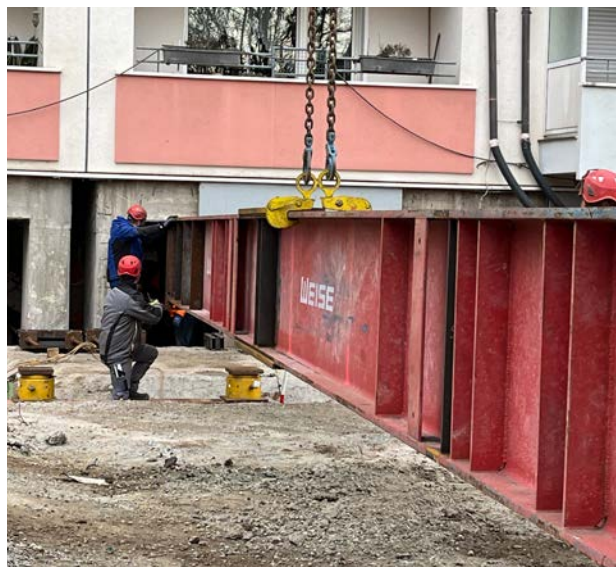
Bild 13.4 Einbau der Traverse Quelle: Bezirksregierung Arnsberg
