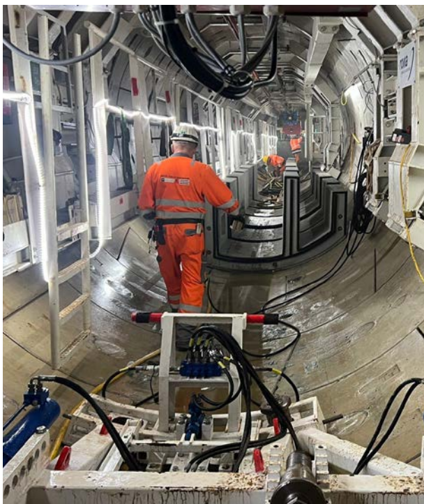
Bild 5.1 Einbau der Gerinne mittels Gerinneeinbauzug Quelle: RAG AG
