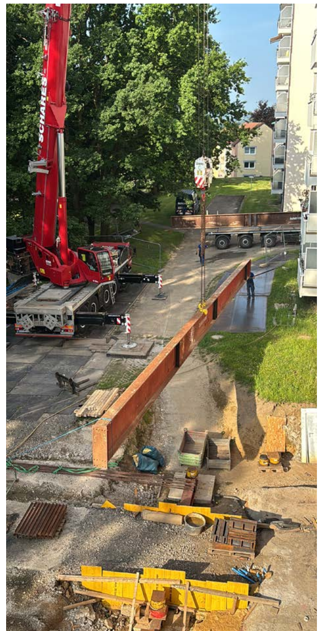
Bild 13.8 Rückbau der Traverse Quelle: Bezirksregierung Arnsberg
