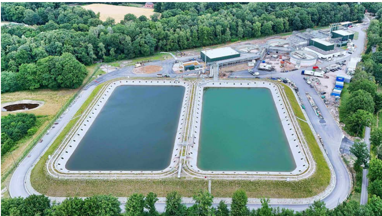
Bild 5.3 Grubenwasseraufbereitungsanlage Gravenhorst Quelle: RAG AG
