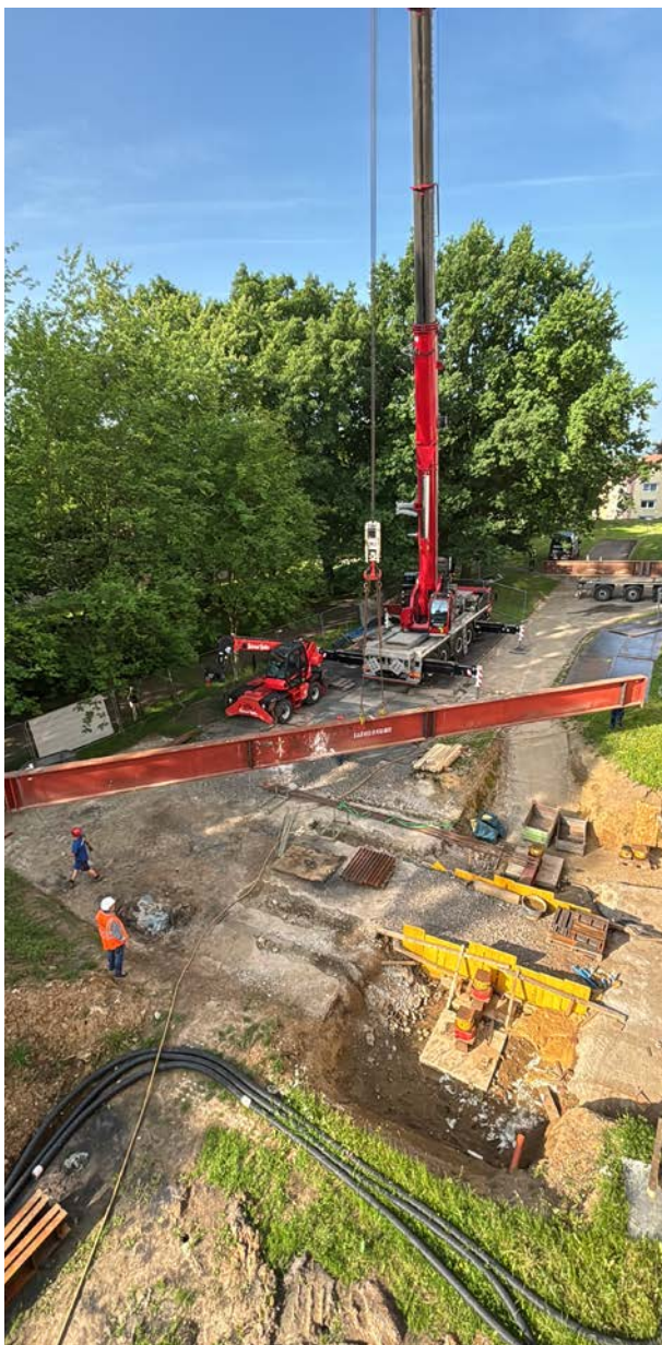
Bild 13.7 Rückbau der Traverse Quelle: Bezirksregierung Arnsberg
