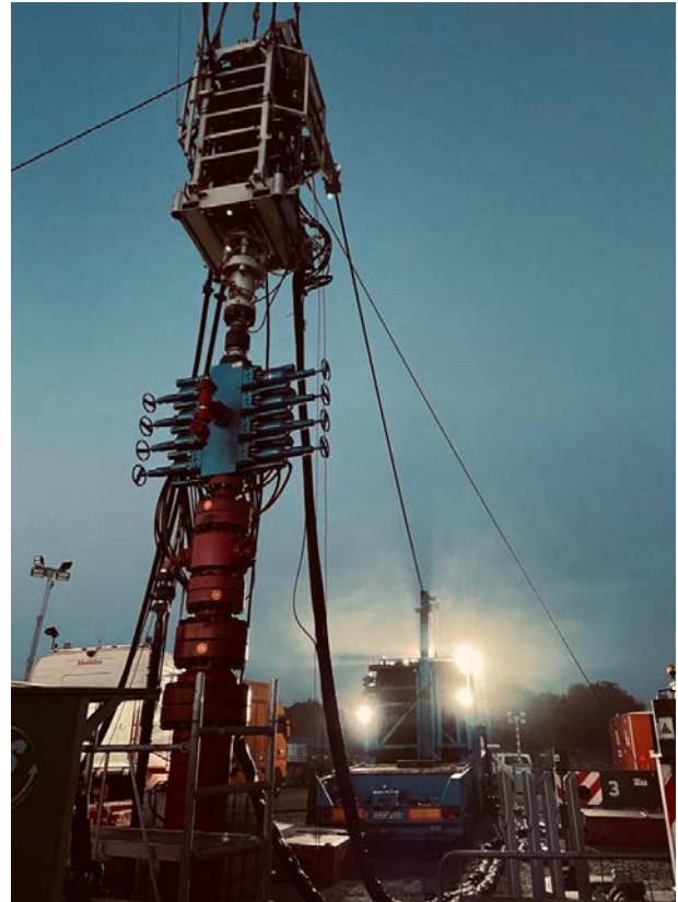
Bild 11.5 Eine aufgebaute CT-Anlage ohne Turmgerüst auf einer Gasspeicherbohrung
