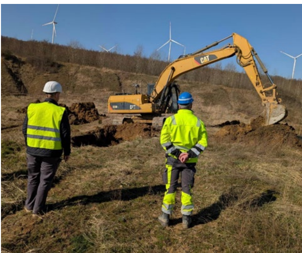
Bild 6.3 –Anlage eines Baggerschurfes (Quelle: Bezirksregierung Arnsberg)
