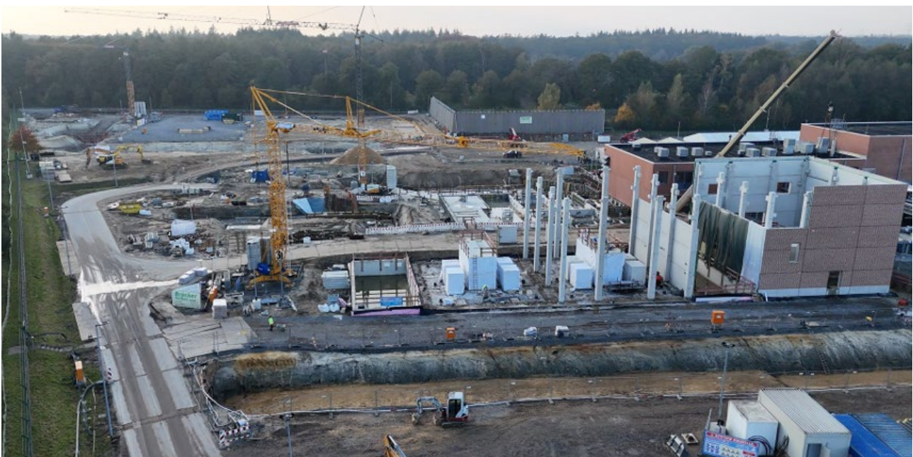
Bild 8.4 – Baufeld mit über 600 niedergebrachten Bohrpfählen (Quelle: RWE Gas Storage West GmbH)
