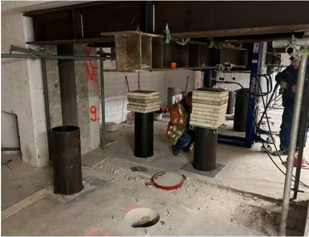
Bild 12.6 – Einbau der Stahlpfahlfundamente im Innenraum (Quelle: Bezirksregierung Arnsberg)
