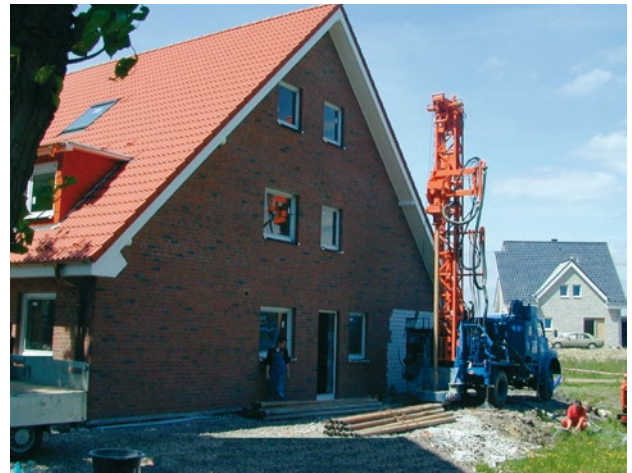
Bild 2.1 – Geothermiebohrung (Quelle: Bezirksregierung Arnsberg)
