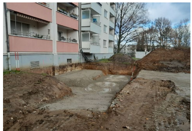
Bild 12.5 – Abgeschlossene Baumaßnahmen im Außenbereich (Quelle: Bezirksregierung Arnsberg)
