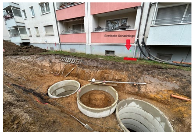
Bild 12.4 – Bau der Brunnenfundamente im Außenbereich (Quelle: Bezirksregierung Arnsberg)
