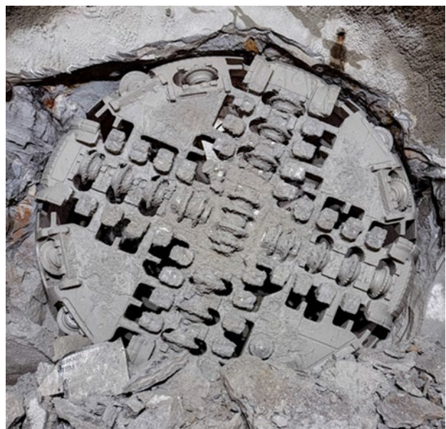
Bild 7.2 – Durchschlag der TBM Ost mit der Demontagekammer an Schacht Oeynhaus 1 (Quelle: RAG AG)
