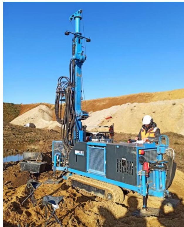
Bild 6.2 – Durchgeführte Bohrung mit Hohlbohrschnecke (Quelle: Bezirksregierung Arnsberg)
