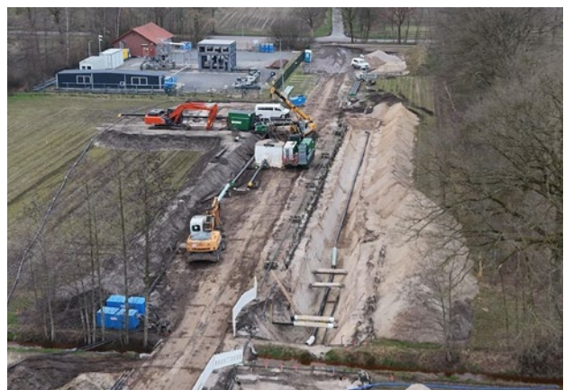
Bild 8.6 – Feldleitungsbau (Quelle: RWE Gas Storage West GmbH)
