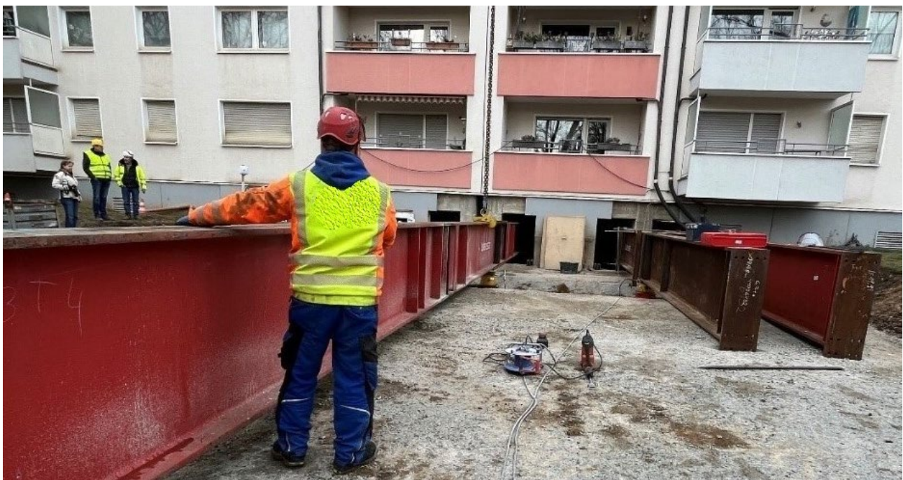
Bild 1.3 – Bauliche Umsetzung des Konzepts zur gefahrlosen Sicherung des unter dem Gebäudeteil A befindlichen Schachtes (Quelle: Bezirksregierung Arnsberg)
