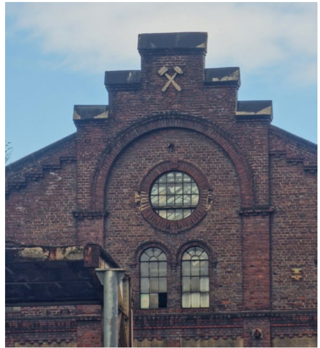
Bild 14.4 – Denkmalgeschützte Maschinenzentrale, hier endete bereits 2024 die Bergaufsicht (Quelle: Bezirksregierung Arnsberg)
