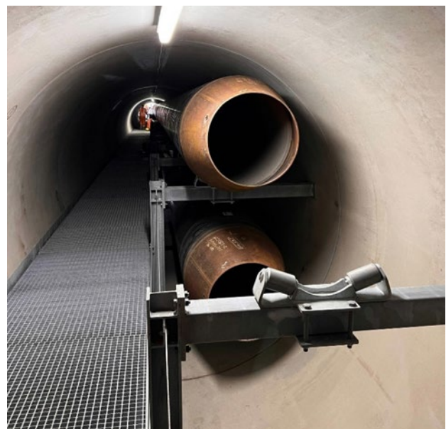
Bild 7.5 – Blick in den Düker DN 2800 (Quelle: Bezirksregierung Arnsberg)
