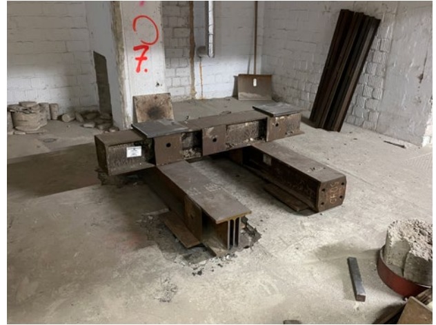
Bild 12.7 – Einsatzbereites Stahlpfahlfundament (Quelle: Bezirksregierung Arnsberg)
