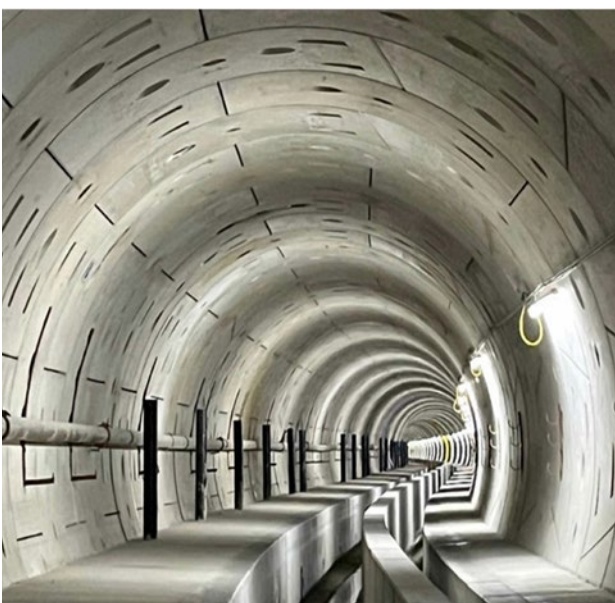
Bild 7.1 – Ausgebauter Grubenwasserkanal mit Gerinnefertigteilen und betonierten Bermen (Quelle: RAG AG)
