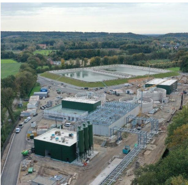
Bild 7.3 – Bau der Grubenwasseraufbereitungsanlage Gravenhorst (Quelle: IBJ Essen)
