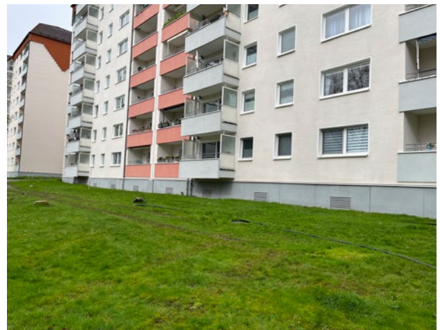
Bild 12.8 – Außenansicht vor Beginn der Baumaßnahmen im Außenbereich – so soll auch der Zustand nach den Sicherungsarbeiten wiederhergestellt werden (Quelle: Bezirksregierung Arnsberg)
