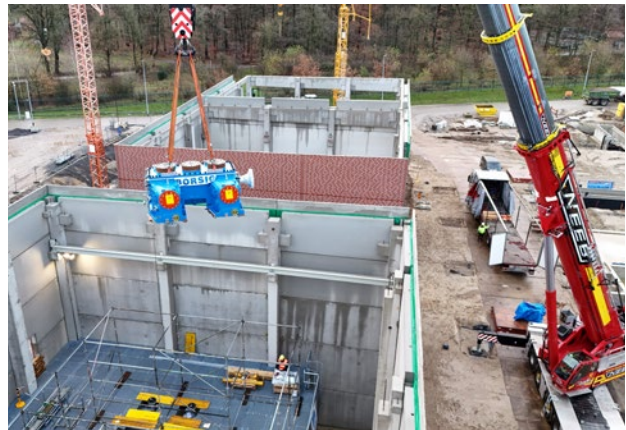
Bild 8.5 – Einheben des Verdichters (Quelle: RWE Gas Storage West GmbH)
