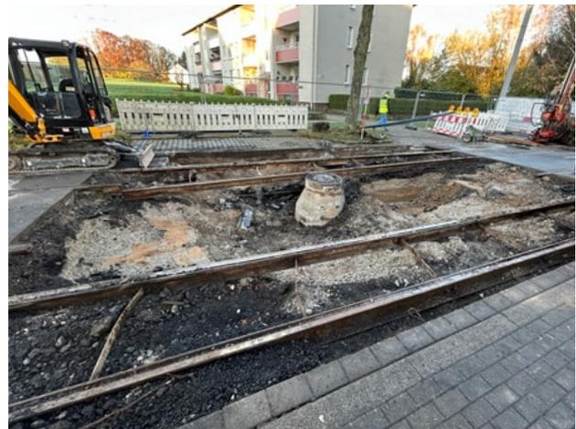
**Bild 1.8** – Tagesbruch ausgekoffert, im Hintergrund rechts ein Bohrgerät für weitere Probebohrungen (Quelle: Bezirksregierung Arnsberg)
