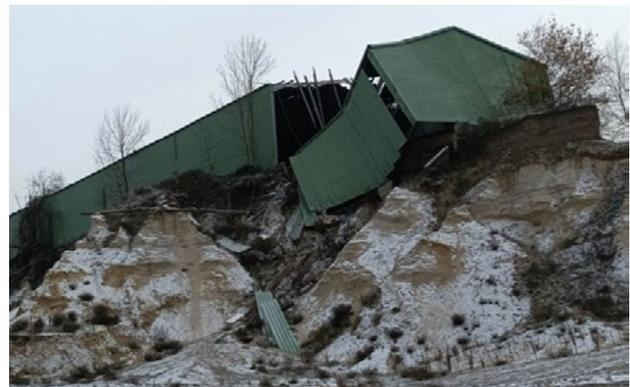
**Bild 3.4** – Beschädigte Halle am unmittelbaren Rand der Erosionsrinne (Quelle: Bezirksregierung Arnsberg)
