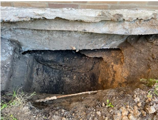
**Bild 1.6** – Tagesbruchstelle direkt an der Außenwand der Schule (Quelle: Bezirksregierung Arnsberg)
