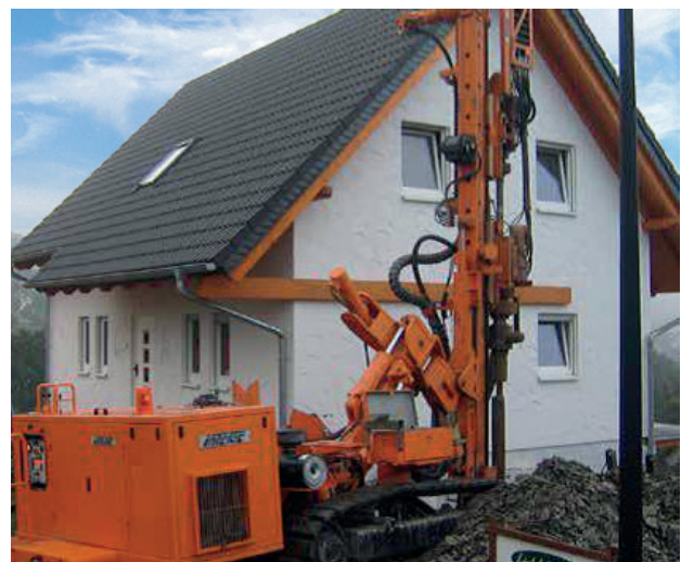
Bild 2.2 – Geothermiebohrung (Quelle: H. Spiekermann Bohrtechnik GmbH)
