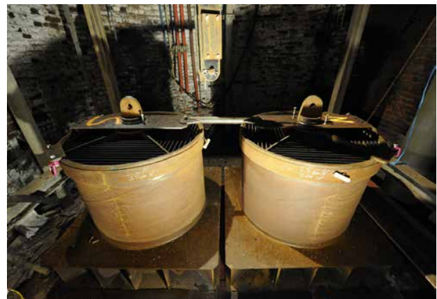
Bilder 8.4 und 8.5 – Betonierbühne für Aufbau Vorbau-schale und Aufbau Hüllrohre (Quelle: RAG AG)
