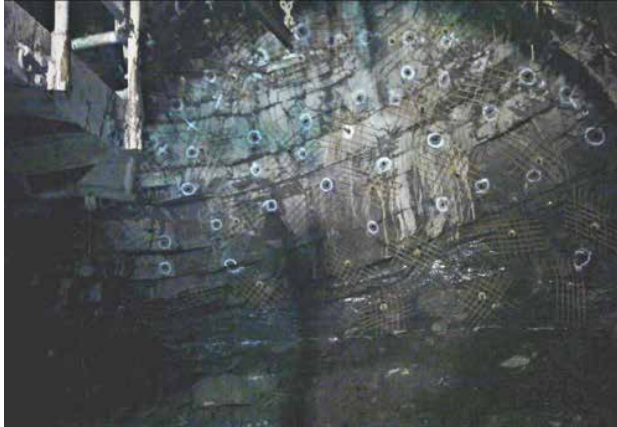
Bilder 7.4 und 7.5 – Anordnung der Sprengbohrlöcher und Leitsprengbild am 20.04.2018 (Quelle: Hanelt)
