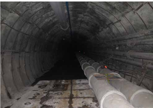
Bild 9.2 – Rohrleitungstrasse im Förderberg
