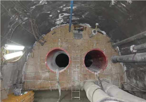
Bild 9.1 – Abschlussdammbauwerk im Förderberg
