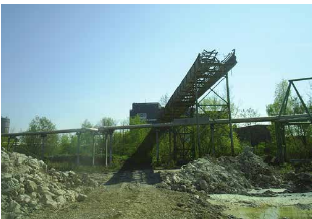
Bild 13.1 – Blick auf die zum Teil zurückgebaute Bandbrücke zwischen der Schachtanlage und der Bergeverladung Prosper II (Quelle: Maximilian Jeglorz)
