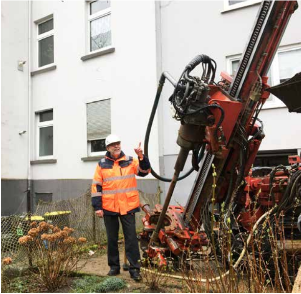
Bild 1.2 – Untersuchungsbohrungen in Wuppertal Langerfeld (Quelle: Friedrich Wilhelm Wagner)
