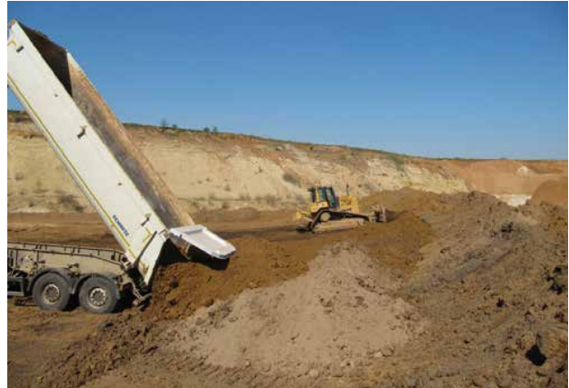
Bild 11.1 – Angeliefertes und aufgehaldetes Bodenmaterial in einem Tagebau vor einer Fremdüberwachung sowie vor dem endgültigen Einbau (Quelle: Waerder, Bezirksregierung Arnsberg)
