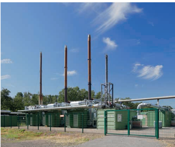
Bild 2.1 – Grubengasverwertungsanlage (Quelle: Friedhelm Krischer)
