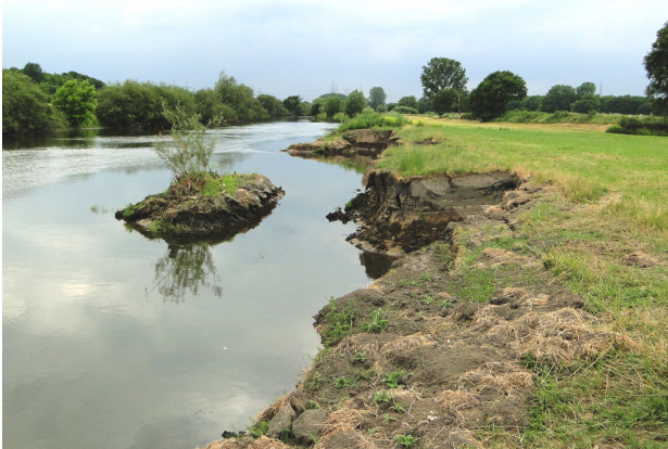
Bild 5.3 – Uferentfesselung an der Lippe (Quelle: Froelich & Sporbeck)
