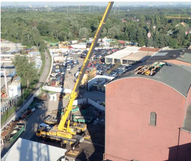
Bild 8.4 – Abtransport der demontierten Teile (Quelle: RAG Deutsche Steinkohle)
