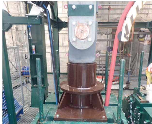
Bild 8.7 – Verlagerung mit Standrohr (Quelle: RAG Deutsche Steinkohle)
