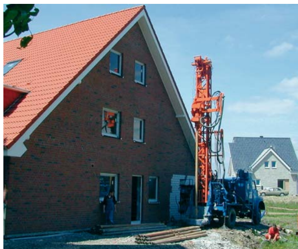
Bild 1.2 – Geothermiebohrung (Quelle: BR Arnsberg)
