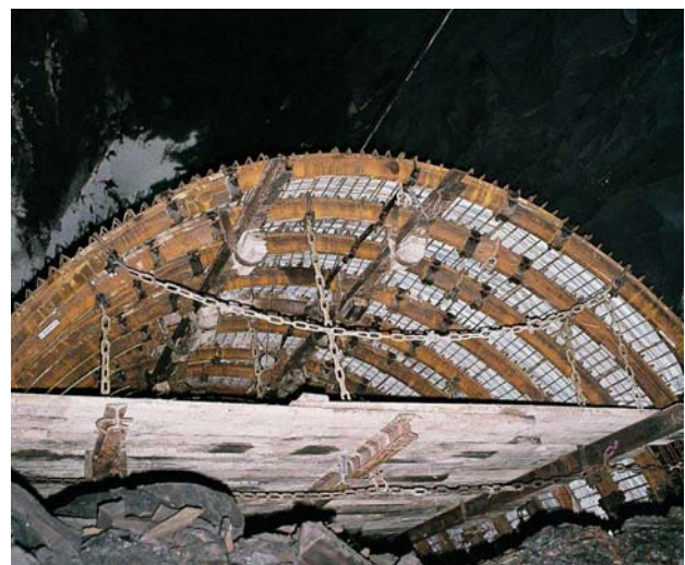
Bild 7.7 – Baustellenfoto mit Ausbaubühne (Quelle: RAG Anthrazit Ibbenbüren GmbH)
