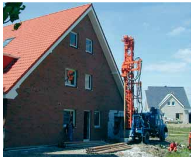
Bild 1.2 – Geothermiebohrung
