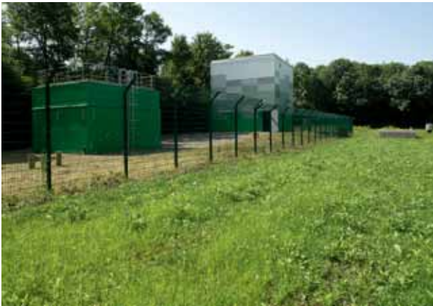
Bild 8.4 – Die Sauerstoffanreicherungsanlage mit Entgasungsbecken im Vordergrund nach Fertigstellung
