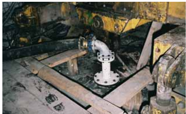
Bild 11.3 – Druckluftanschluss in der Bohrkammer
