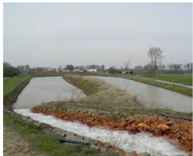
Bild 5.4 – Kaskaden zur Eisenausfällung an der Einleitstelle Jülich-Kirchberg
