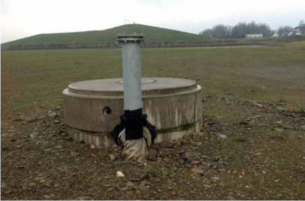
Bild 10.6 – Sicherungsmaßnahmen an Schacht 1
