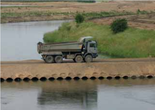
Bild 7.3 – Stahlrohrbrücke über die alte Lippe (Quelle: Lippeverband)
