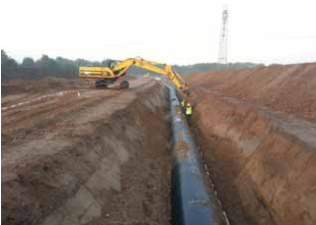
Bild 8.7 – Verlegung der Wiebachleitung III in offener Bauweise
