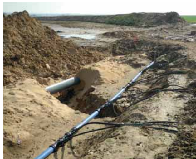
Bild 5.3 – Sumpfungswasserzuleitung zur „Beheizung“ von Spargelfeldern
