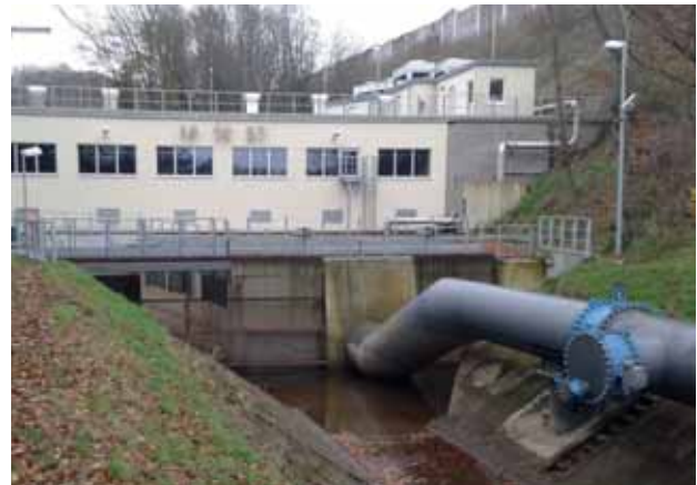
Bild 8.8 – Die sanierte Pumpstation Götzenkirchen
