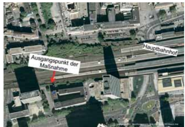
Bild 12.1 – Luftbild Schadens- und Arbeitsbereich
