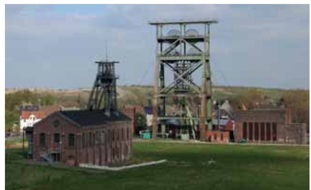
Bild 10.8 – Folgenutzung als Denkmal : Tagesschächte Gneisenau 2 und 4
