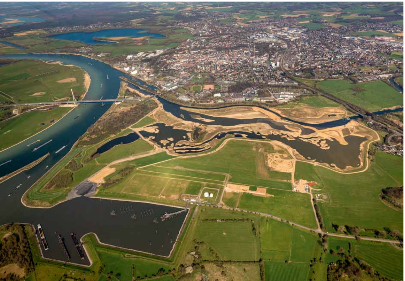
Bild 7.4 – Lippemündung kurz vor Verschließen des alten Lippebettes 2014 (Quelle: Lippeverband)
