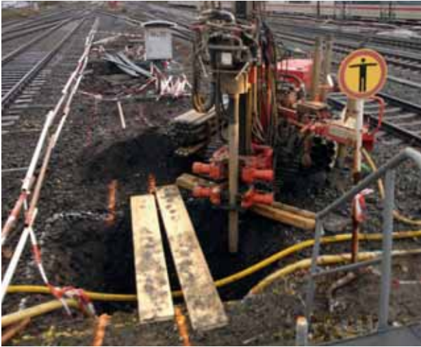
Bild 12.6 – Bohrarbeiten im Gleisbett
