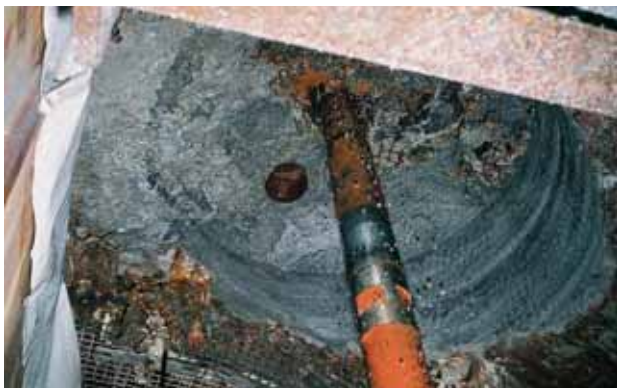
Bild 11.2 – Erweiterungsbereich mit zusätzlicher Pilotbohrung zur Bewetterung
