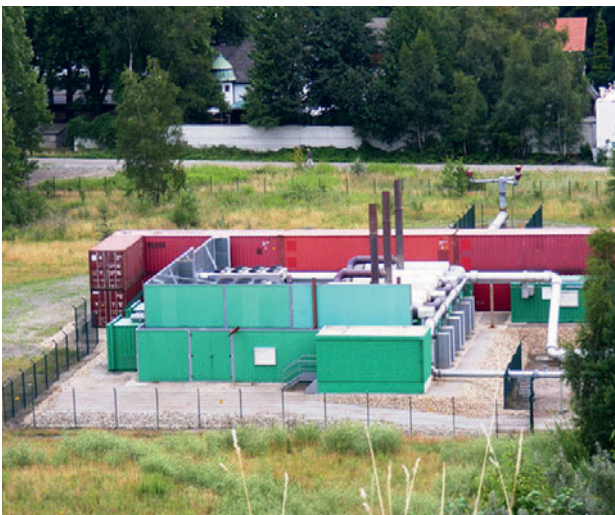
Bild 1.1 – Grubengasverwertungsanlage
