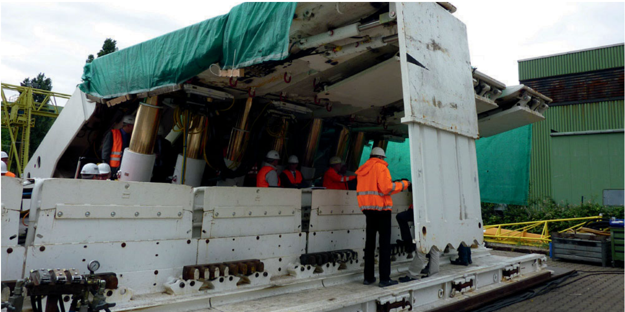
Bild 7.4 – Probeaufbau Schildausbau (Gewicht 39 t)
