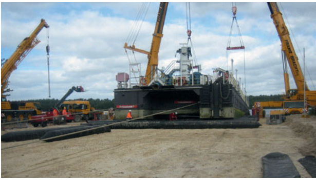
Bild 6.1 – Bagger auf Luftkissen (Quelle: Quarzwerke GmbH)
