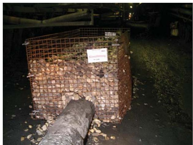
**Bild 3.6** – Rohrleitung mit Kiesschüttung
