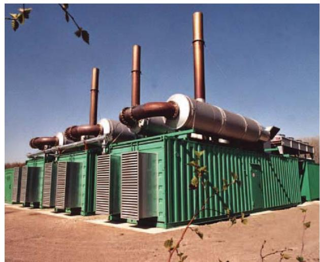
**Bild 1.1** – Grubengasverwertungsanlage
